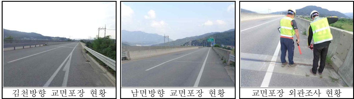
【그림 3.3】 교면포장 현황
