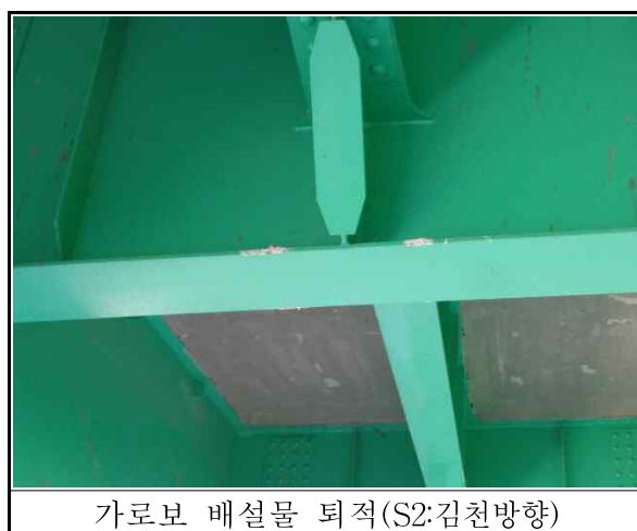
【그림 3.13】 Steel Box Girder외부 손상 현황
