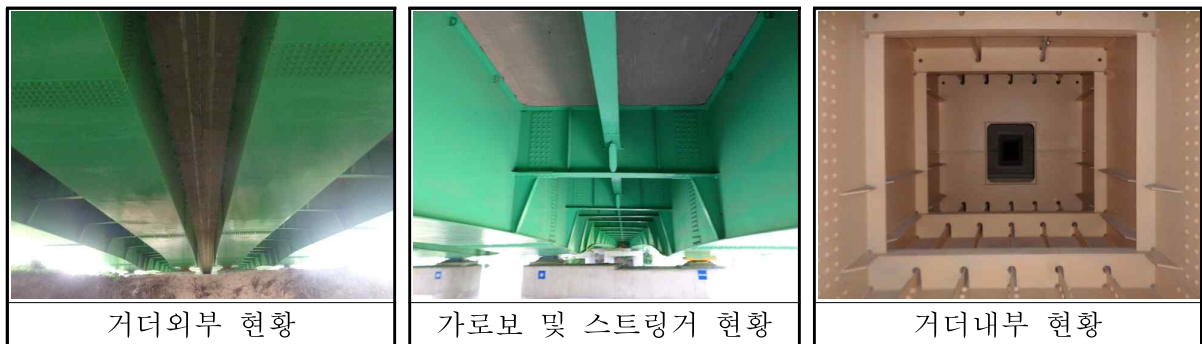
【그림 3.11】 Steel Box Girder 현황
