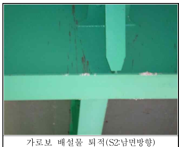
【그림 3.13】 Steel Box Girder외부 손상 현황
