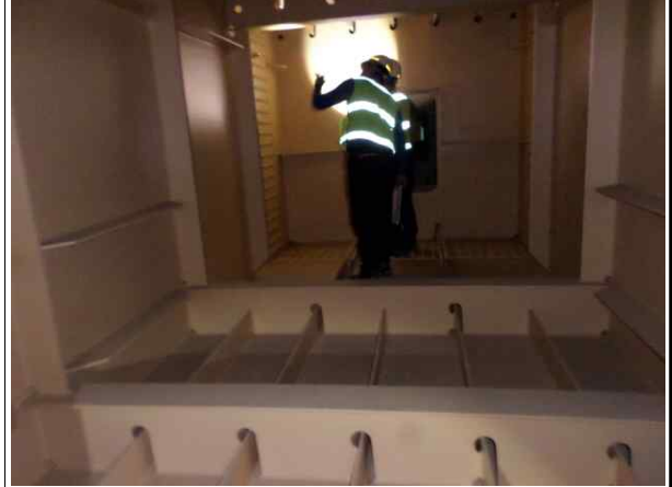
거더내부 외관조사(2인 1조)
