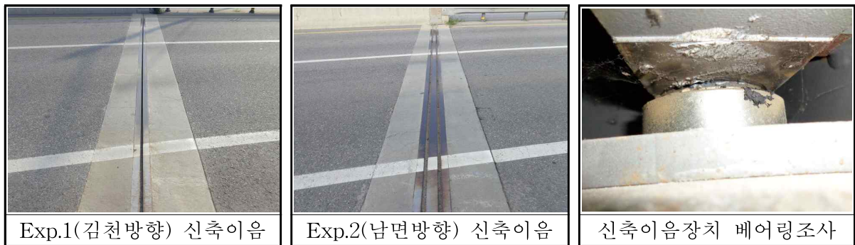
【그림 3.23】 신축이음장치 현황 및 외관조사
