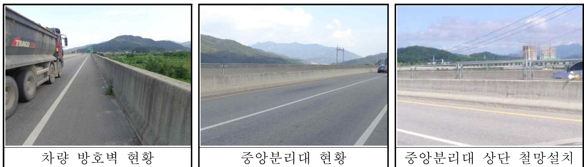
【그림 3.5】 방호벽/중앙분리대 현황
