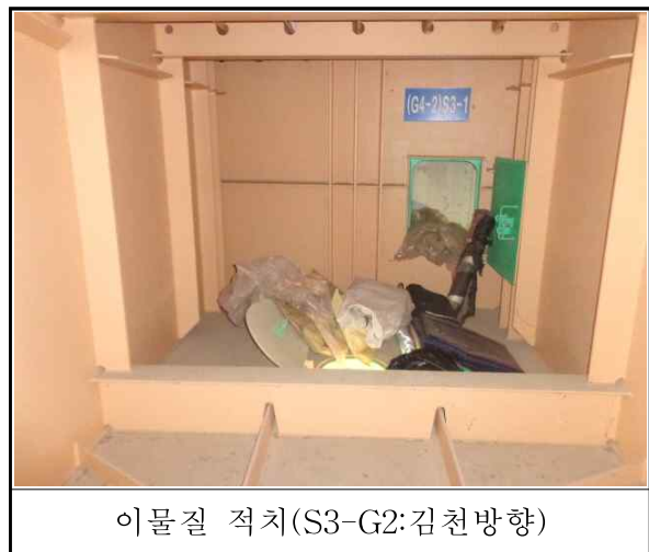
【그림 3.15】 Steel Box Girder내부 손상 현황
