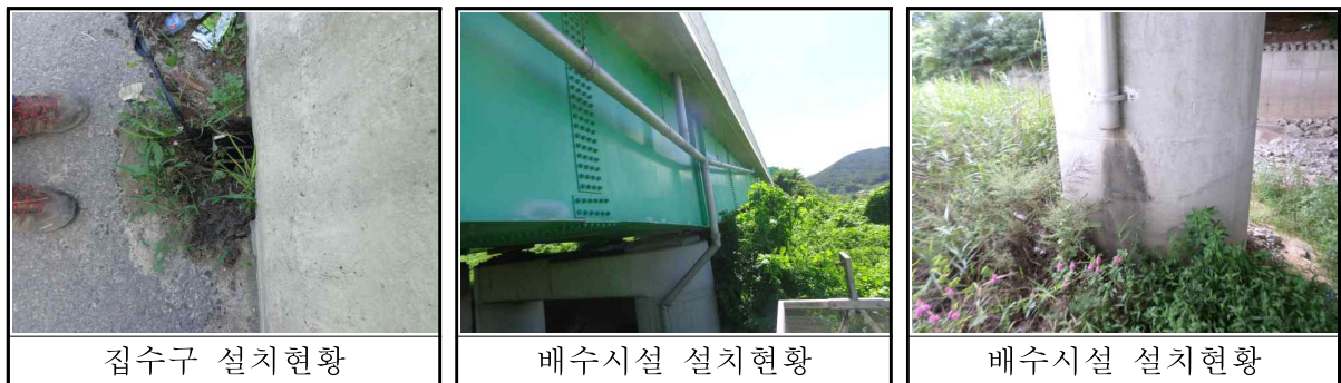
【그림 3.27】 배수시설 현황
