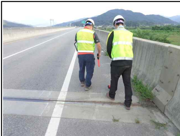
교량상부 외관조사(3인 1조, 도보조사)
