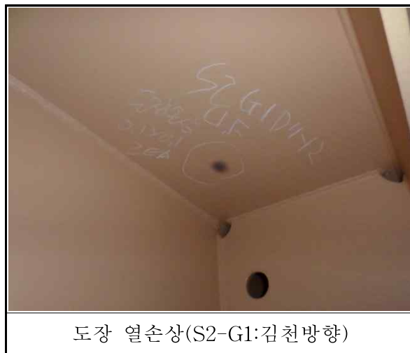
【그림 3.15】 Steel Box Girder내부 손상 현황
